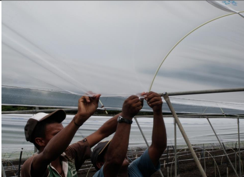
Sujeción del plástico con cinta adhesiva
